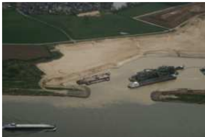
Hoogwatergeul Lomm in uitvoering. Foto: Delfstoffen Combinatie Maas dal
